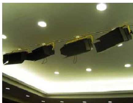
Figura 22: Proiectoare de tavan, care asigură iluminarea corectă a zonelor importante pentru camerele foto și de televiziune
