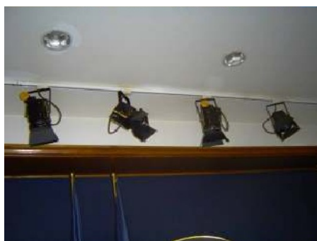
Figura 22: Proiectoare de tavan, care asigură iluminarea corectă a zonelor importante pentru camerele foto și de televiziune
